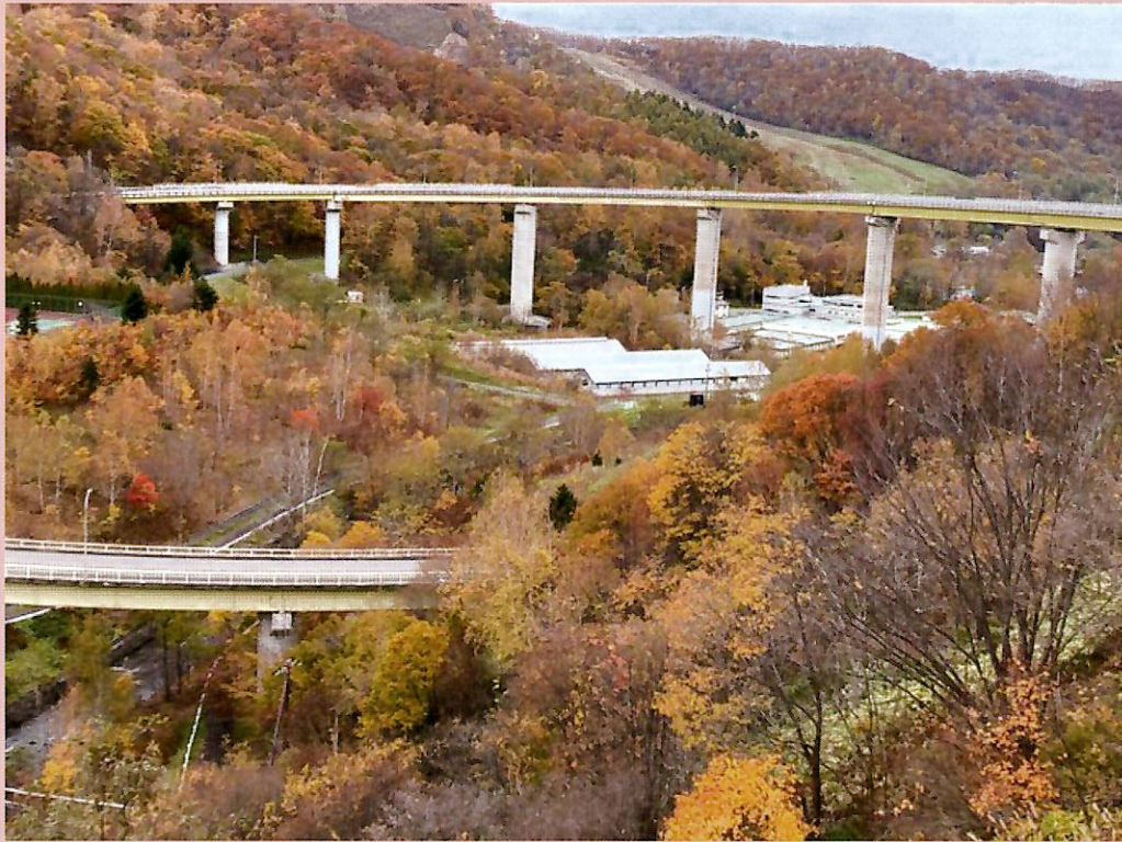
朝里ダムから望むループ橋
